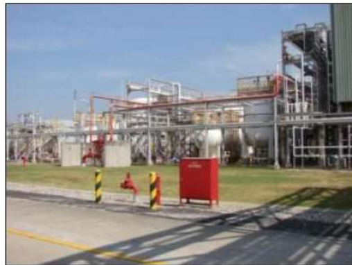
ถังดับเพลิง และระบบดับเพลิงบริเวณเขตการผลิต
