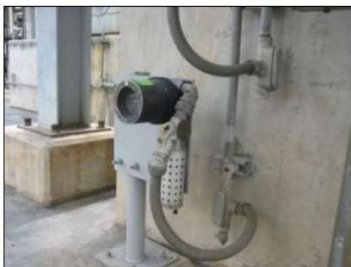
อุปกรณ์ตรวจสอบการรั่วไหลของก๊าซ (Gas Detector)
