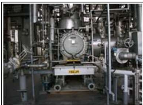
ภาพที่ 2.2-4 ปั่นชนิด Double mechanical ที่ใช้ภายในพื้นที่โครงการ
